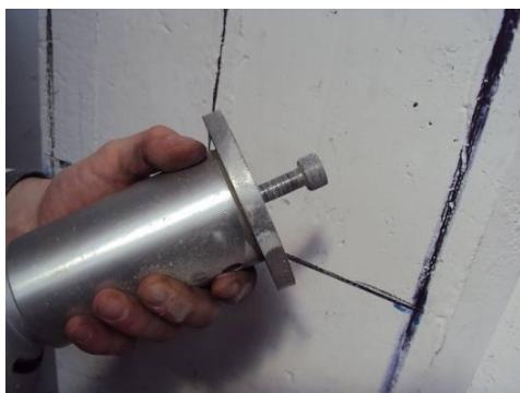
Fase 4: esecuzione alesaggio con fresa diamantata \varnothing 18 mm
