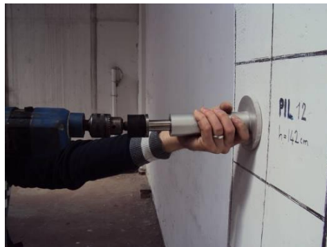
Fase 3: esecuzione perforazione con punta al widia \varnothing 18 mm
