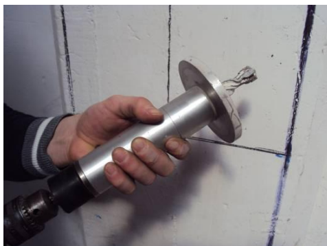
Fase 3: esecuzione perforazione con punta al widia \varnothing 18 mm
