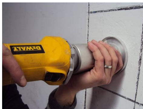
Fase 4: esecuzione alesaggio con fresa diamantata \varnothing 18 mm
